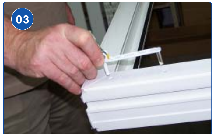
INSTALL BOTTOM HINGE
